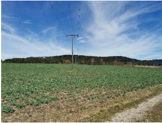
Blick von Süden über das Plangebiet, zu sehen ist die in Nord-Süd Richtung verlaufende 20 kV Leitung. Diese wird abgebaut und erdverlegt.
